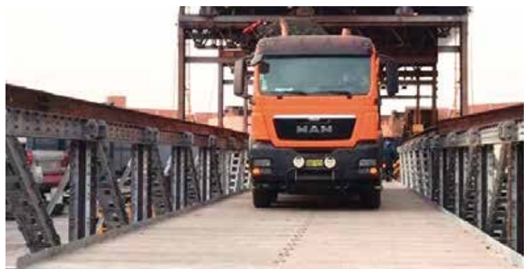
En el Perú la empresa Esmetal ha desarrollado un puente modular que se adapta a las necesidades propias del país, que va desde los 12 hasta los 60 m con uno o dos carriles, dependiendo el requerimiento del cliente.
